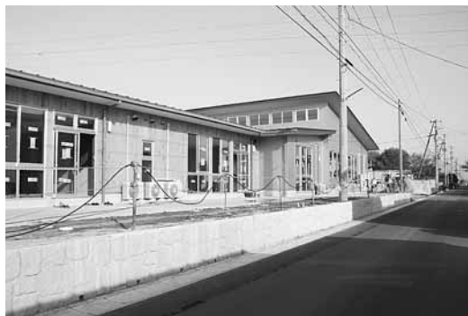
建設中の鹿島台子育て支援総合施設なかよし園
