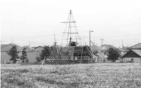
ボーリング調査の様子
