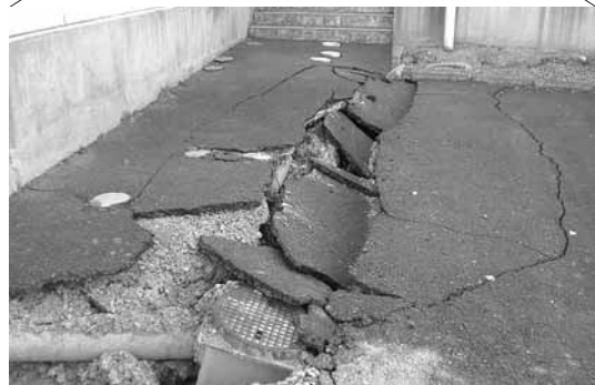
古川総合体育館
