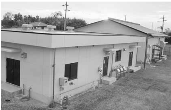
安全で安心な水の供給（清水浄水場）
