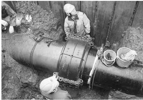
広域水道の復旧現場
