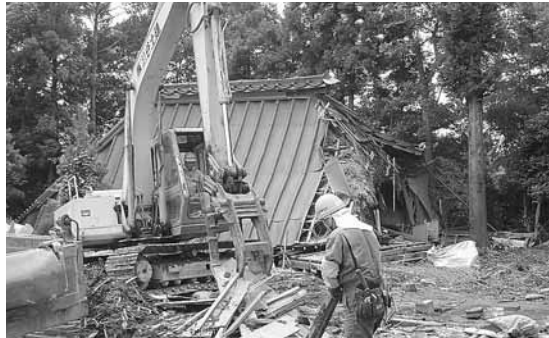
全壊家屋の解体
