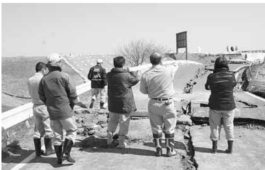
4月5日 建設常任委員会による現地調査
