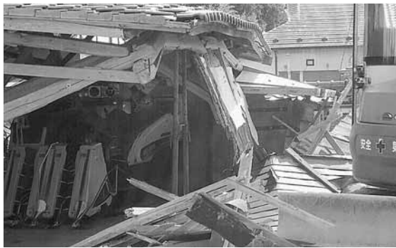
震災で全壊した作業場
