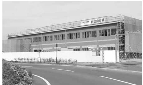
建設中の岩出山分院
