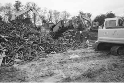
ストックヤードの廃材処理
