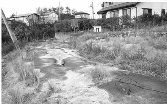
被害が甚大だった宅地
