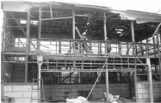
全壊し解体中の地区集会所
