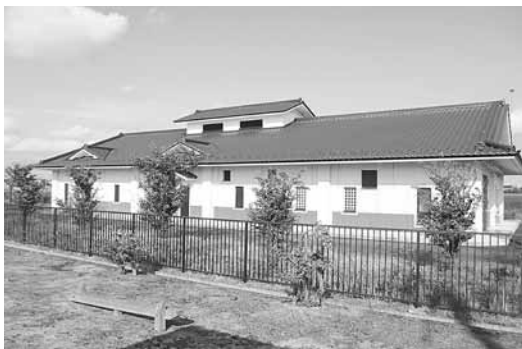
飯川地区農業集落排水処理施設
