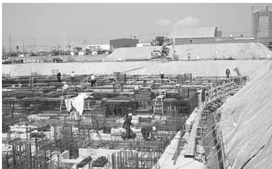
市民病院本院建設現場
