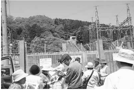
池月水力発電所
