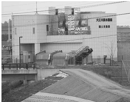
大江川排水機場
