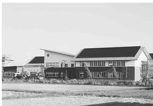
完成間近の松山小学校
