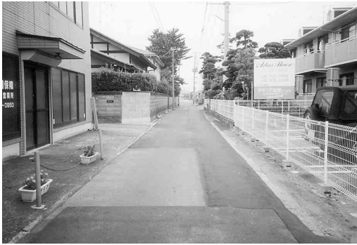
補修工事された市道小金丁南線
