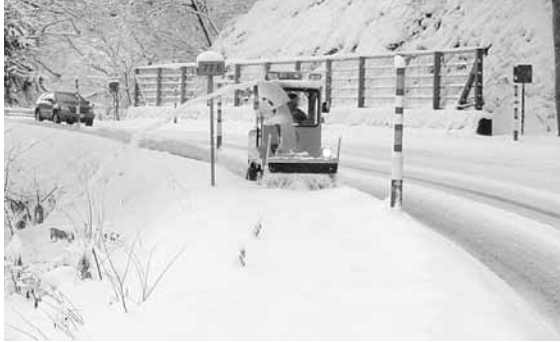
歩道の除雪作業（鳴子温泉地域）
