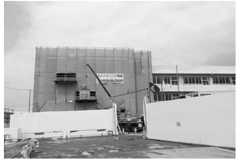
古川第四小学校増築工事現場
