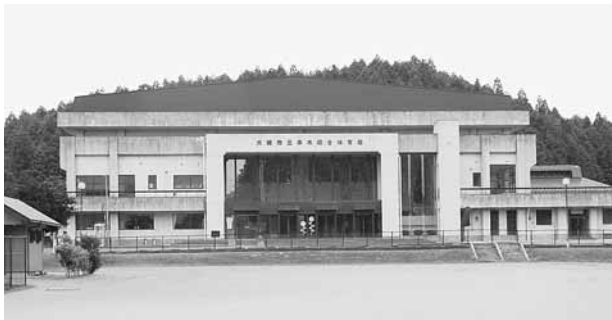
老朽化する社会体育施設（三本木地域）
