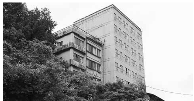
大型空き家 (鳴子温泉地域)
