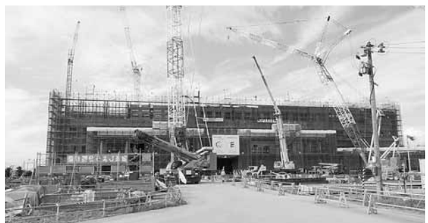
新市民病院の建設現場（8.1現在）
