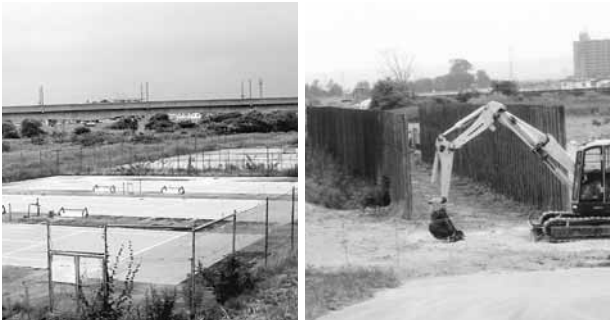
復旧が待たれる堤防と河川公園 (古川地域)
