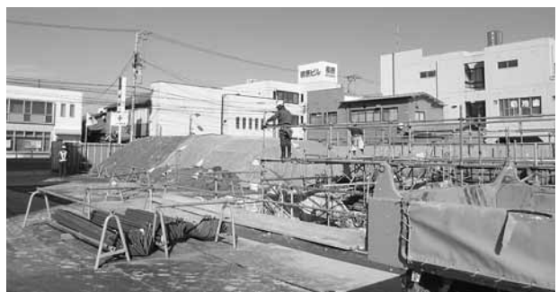
災害復興住宅建設現場（古川駅前大通り）
