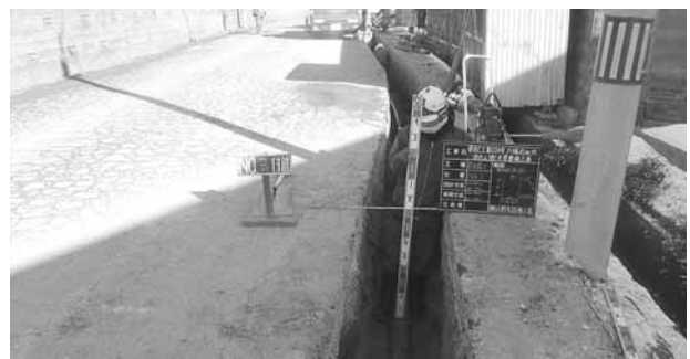
配水管整備工事（岩出山地域）
