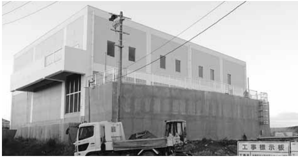
古川李埵雨水排水ポンプ場工事現場
