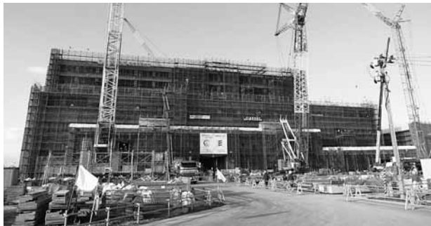
新市民病院の建設現場（11.1現在）
