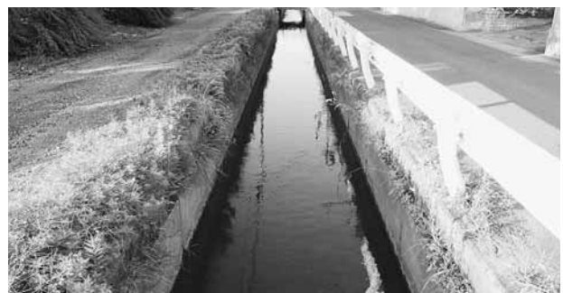
汚泥が堆積する用排水路
