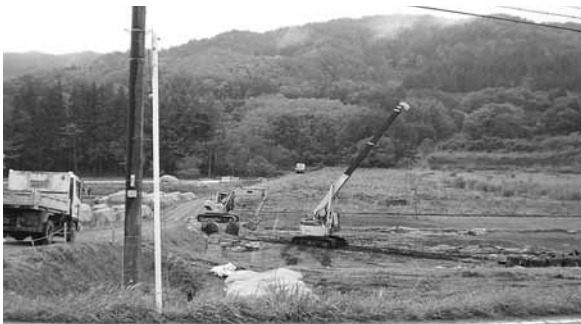
放射能除染作業(福島県飯館村)
