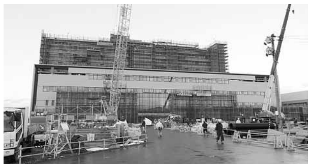
新市民病院の建設現場 (H26.1.6現在)
