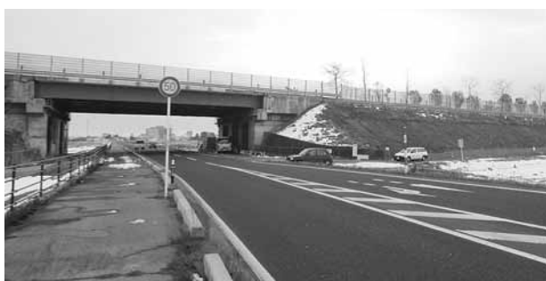
救急車専用高速道退出路の建設現場（古川地域飯川地区）
