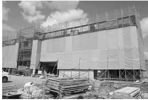
建設中の災害公営住宅（古川駅前大通）
