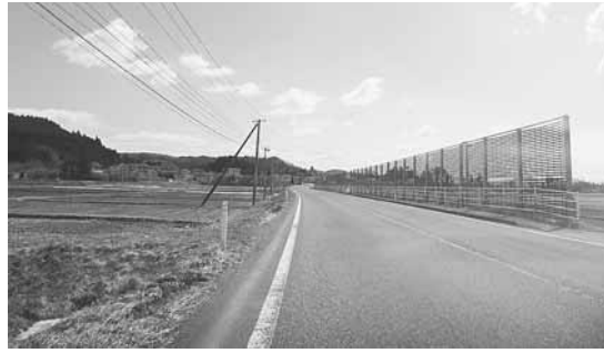
歩道のない国道47号（岩出山地域）
