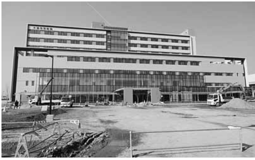
新市民病院の建設現場 (3.24現在)
