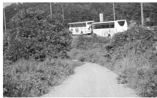
整備が待たれる未舗装アクセス道路（古川地域）
