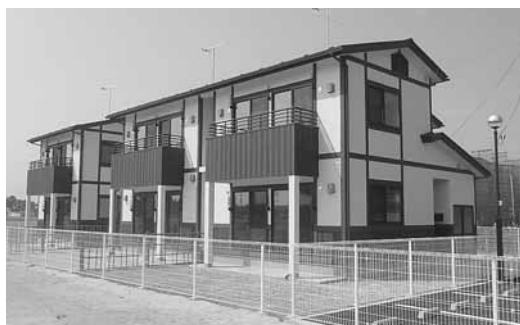
完成した災害公営住宅（田尻地域）
