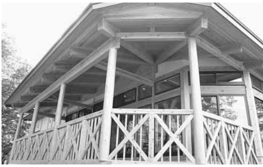
市産材を活用した「鳴子峡レストハウス」
