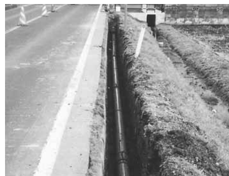
水道管更新工事
