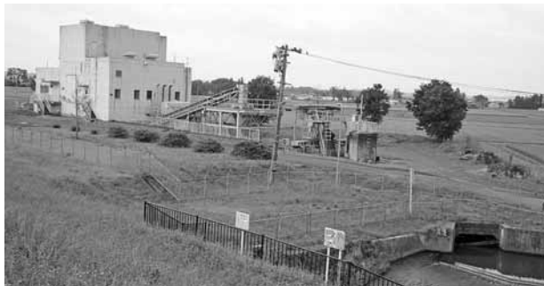
古川 楡木 (たまのき) 雨水排水ポンプ場
