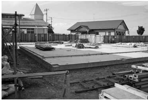
松山幼保一元化施設の建築現場（7.27現在）
