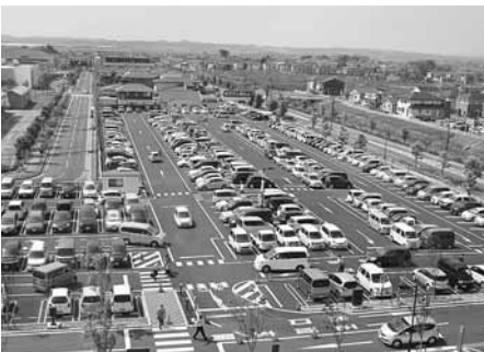
大崎市民病院本院駐車場の様子
