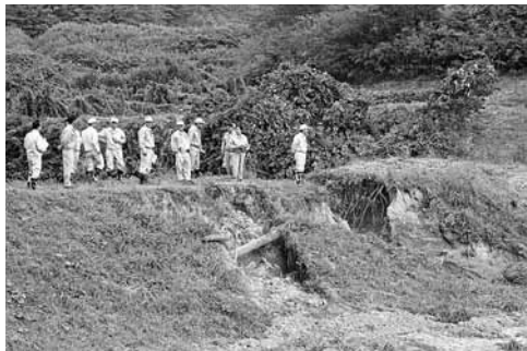
農業用ため池の決壊状況（岩出山地域）
