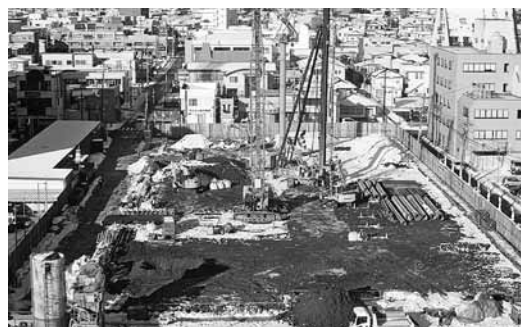
大崎市図書館等複合施設の建設現場（1.20現在）
