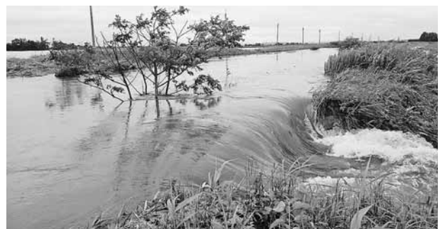
名蓋川の堤防決壊状況（古川地域高倉地区）
