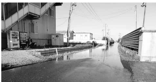
対策が待たれる常襲冠水道路（三本木地域高柳地区）
