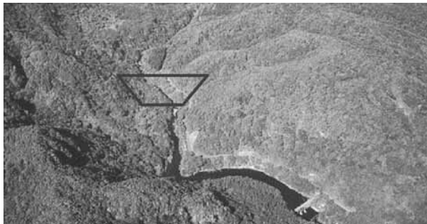
筒砂子ダム建設予定地 (加美町)
