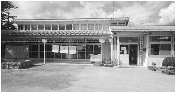
統廃合が検討されている池月保育所 (岩出山地域)
