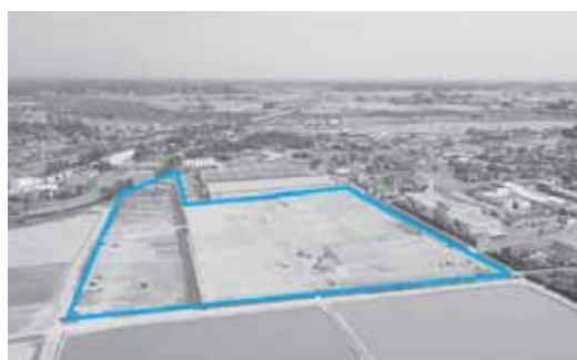
新たに整備された北原工業団地（古川地域）
