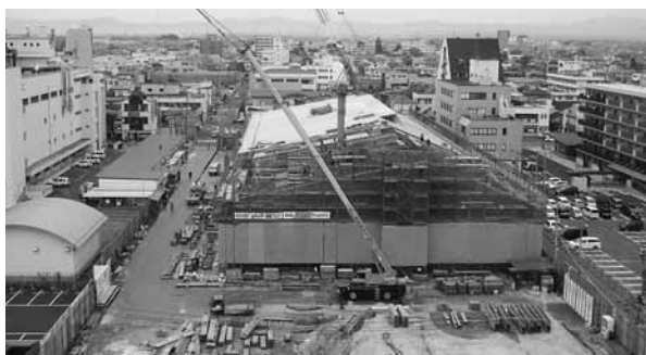
新図書館建設現場 (10月31日現在)
