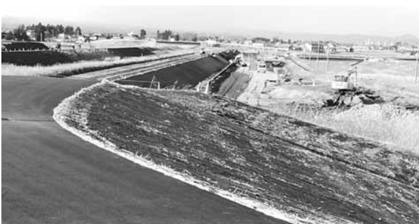
渋井川堤防の改修工事
