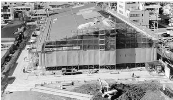
新図書館建設現場 (1月31日現在)
