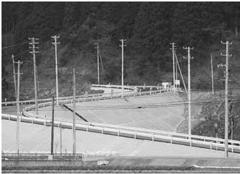
国道108号仮設道路
