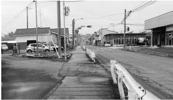
早期完成が待たれる千石堀排水路
