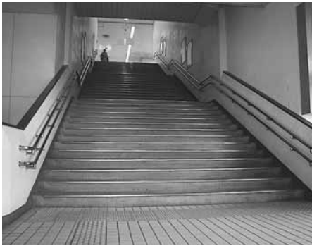
エスカレーターが設置されるJR古川駅南側階段
