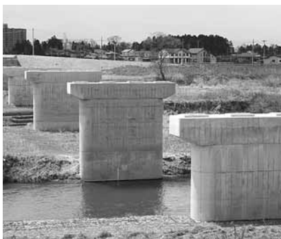
工事が進む東江合橋
