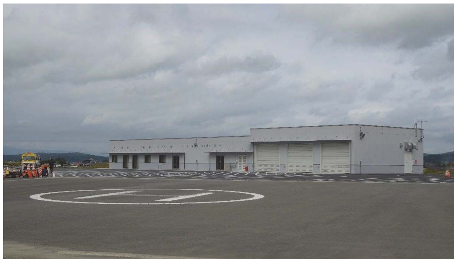
図 3-2 2 志田谷地防災センター
