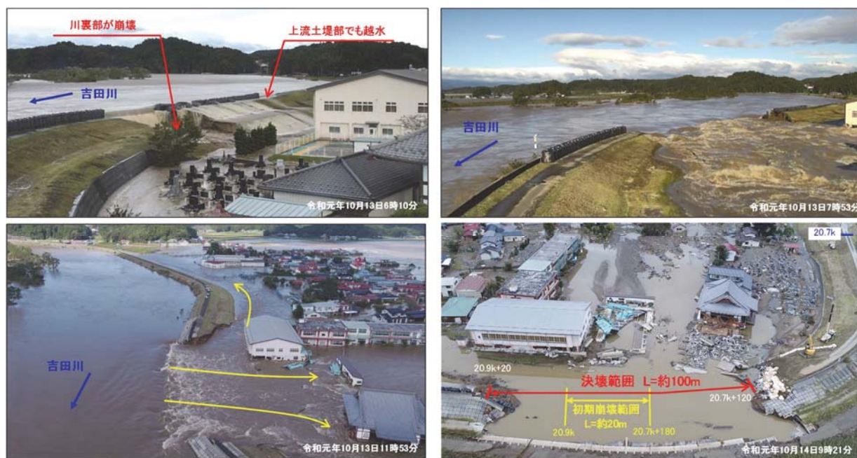
図 3-6 吉田川堤防決壊の様子
